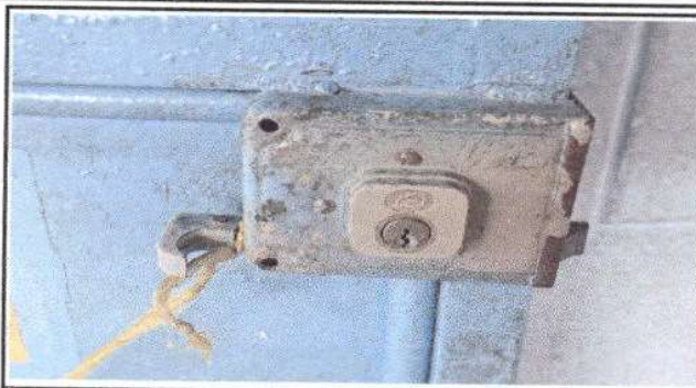
Foto 2: MÓDULO 2 AULAS PUERTAS DE METAL: Mantenimiento a estructura (lijado, cambio de tubo , cepillado, sujeciones, aplicación de pintura); Sustitución de chapa
