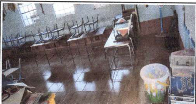
Foto 4: MÓDULO 2 AULAS PISO: Sustitución de piso de cemento líquido; Sustitución de piso de granito
