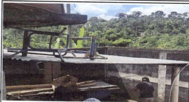
Foto 1: MÓDULO 1 COCINA : CUBIERTA DE LÁMINA: Sustitución de lámina, por lámina troquelada aluzinc calibre 26; ESTRUCTURA DE TECHO: Sustitución de estructura de soporte de metal
